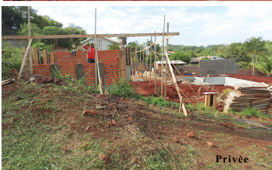
Rua Sabiá ao lado do almoxarifado
